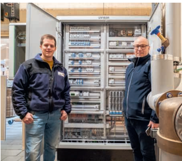
Fabio Rüegger und Tom Haller von StWZ Energie AG vor der neuen Hauptverteilung des Pflanzencenters.
